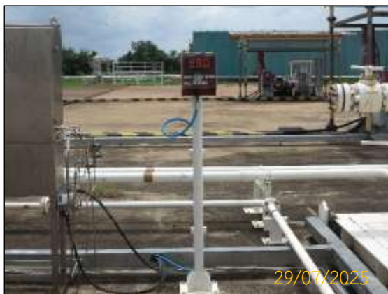
ภาพที่ 2.2-22 อุปกรณ์หยุดการทำงานฉุกเฉิน (OSD/ESD)
