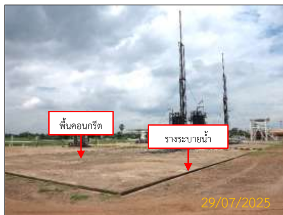
ภาพที่ 2.2-3 พื้นคอนกรีต และรางระบายน้ำล้อมรอบ
