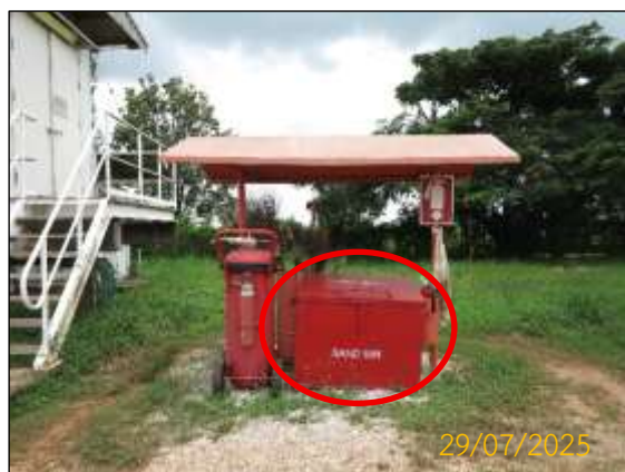
ภาพที่ 2.2-1 อุปกรณ์จัดครบน้ำมัน
