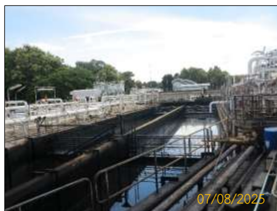
ภาพที่ 2.2-5 API Separator ที่สถานีผลิตลานกระบือ
